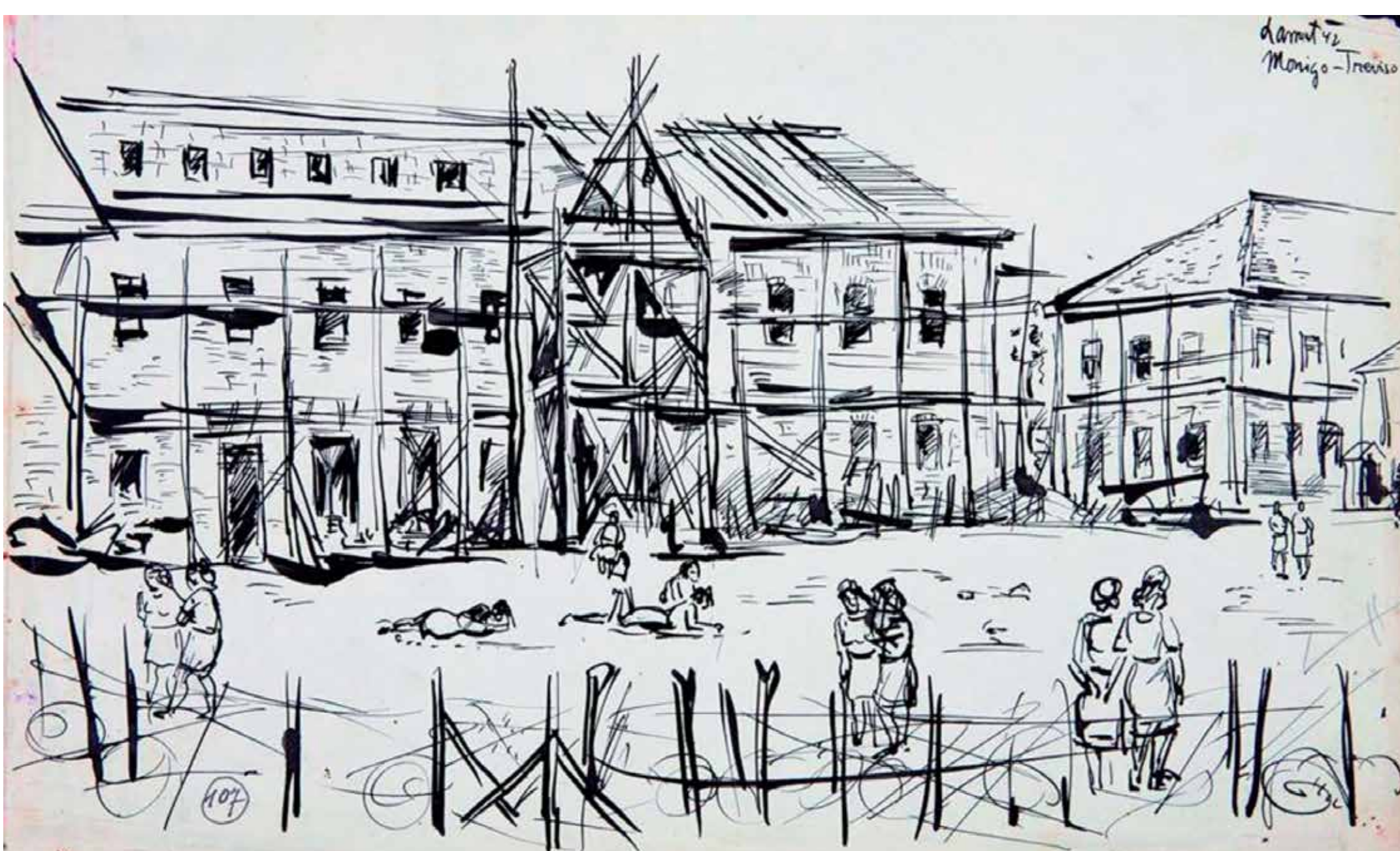
disegno di V. Lamut (in costruzione)
